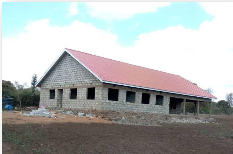
November 2022: Der Rohbau ist fertig
